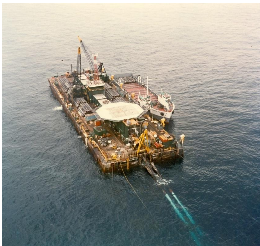
Foto: Aanleg van de NGT pijpleiding begin jaren 70.
